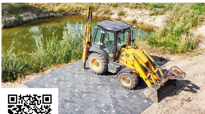
Robocza droga dla pojazdów budowlanych
