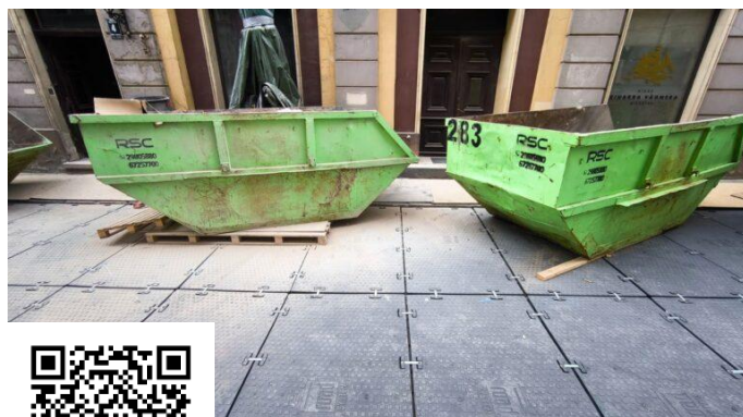
Zabezpieczenie zabytkowego bruku w Rydze
